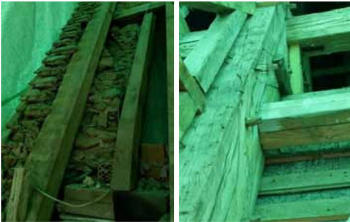
teten Bruchsteinen besteht, wurde ohne moderne Baumaschinen, hauptsächlich mit der Arbeitskraft der Hände und mit den wenigen mechanischen Hilfsmitteln der damaligen Zeit errichtet (Bild links). Deutlich sind die Holznägel zu sehen, welche damals verwendet wurden. Bauteile konnten sich dadurch nicht verschieben und die Konstruktion wurde stabilisiert. Soweit es technisch möglich ist, wird diese Verbindungstechnik auch bei der Sanierung unserer Kirche eingesetzt (Bild rechts).
