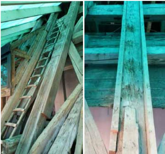
Die Dachplatten wurden abgenommen und die grüne Abdeckplane dient als Wetterschutz, weshalb die Bilder eine grünliche Färbung aufweisen. Inwieweit die Dachziegel wieder verwendet werden können, wird noch geprüft, es wird jedoch davon ausgegangen, dass auch neue Ziegel benötigt werden. Da die Form dieser Ziegel nicht dem
