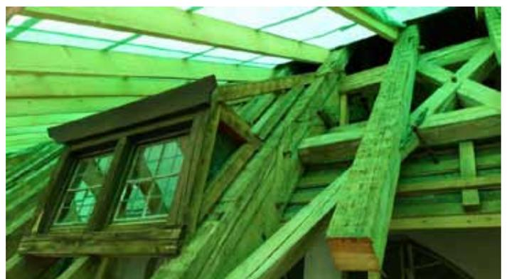
Hier sehen wir bereits restauriertes Gebälk. Soweit möglich, wurden die alten Hölzer aus dem 15. Jahrhundert belassen und nur die Schadhaften durch perfekt angepasste neue Hölzer ersetzt.
