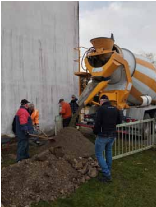
Der Beton wird verarbeitet .....
